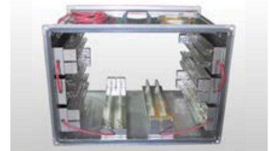
BÄRO UV-C Lampen im Luftkanal positioniert (LOG 0,8 - 89,8% Reduktion)
