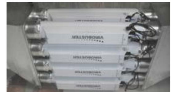
Virobuster Steritubes Moduln, als 2x4 Cluster zwischen den Luftkanal eingebaut (LOG 3,6 - 99,98% Reduktion)
